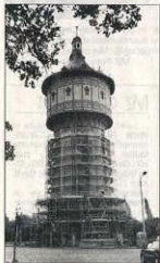
Teile des Wasserturms Nord sind derzeit dezent verhüllt.
